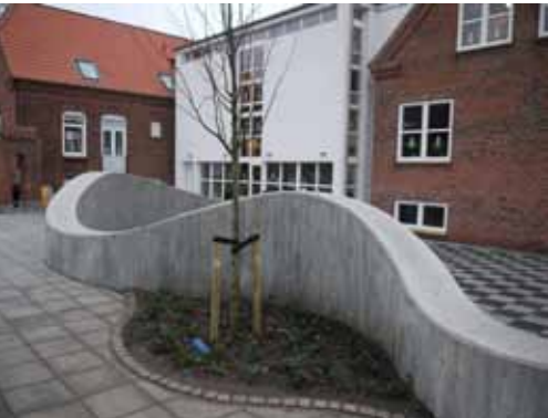
Eksempel på et element som er overgang mellem forplads og vej. På samme tid afgrænser og leder muren fodgængere (Skive).
