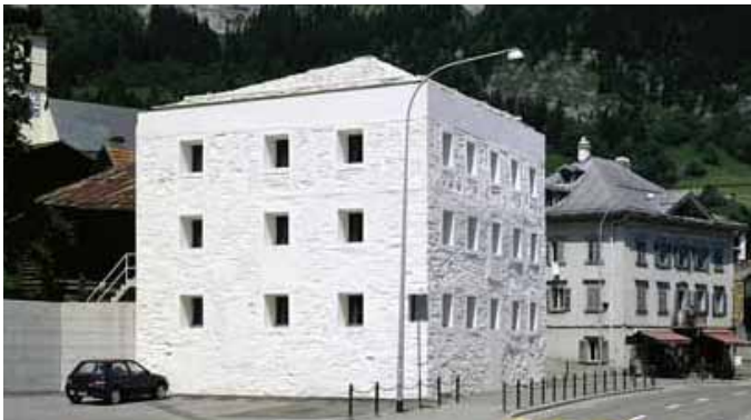
Renovering af bygning som efter at have stået tom i 22 år nu er et museum (Das gelbe Haus i Flims, Schweiz).
